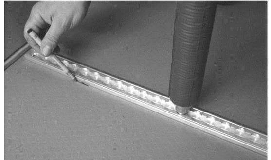
Anschließend wird die Aufnahme für die Bodenschiene mit der Oberfräse 35mm breit und 10mm tief eingefräst (Achtung, Plattenstärke beachten!).
